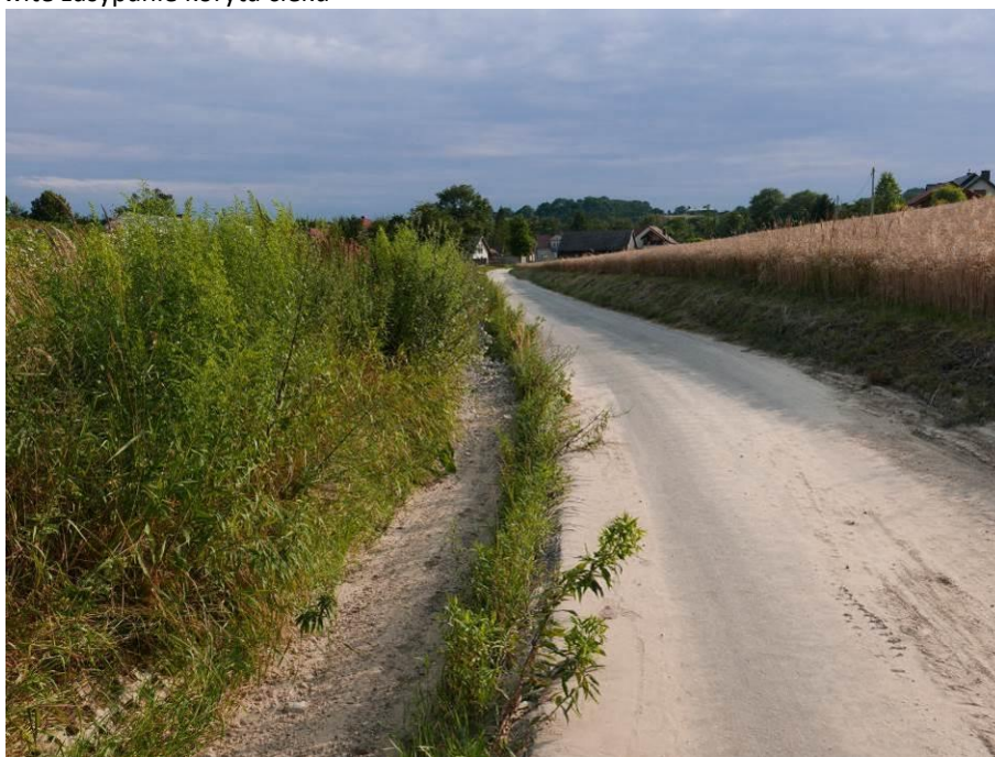
Fot. 55. Całkowite zasypanie koryta ciek
