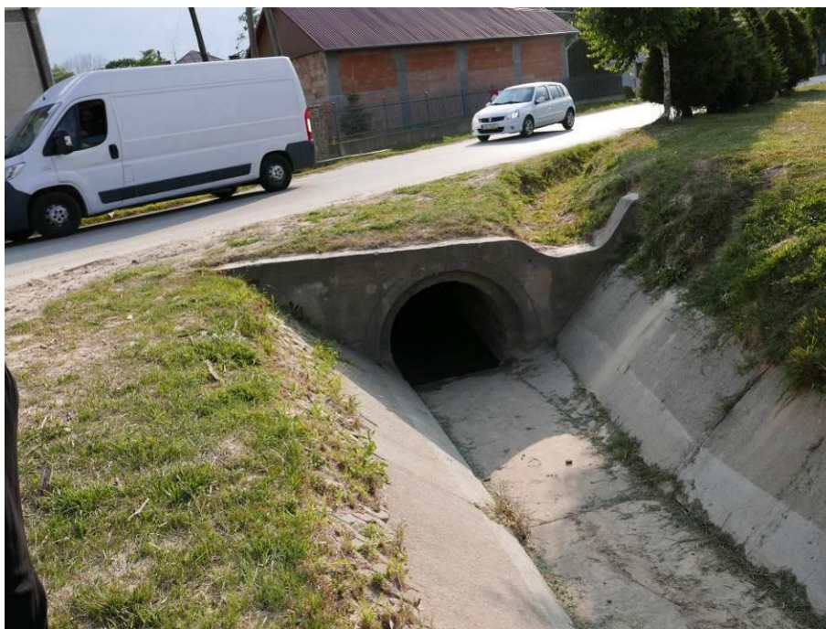
Fot. 65. Istniejący przepust pod droga powiatową
