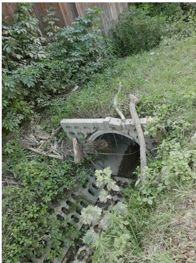
Fot. 74. Przepust rurowy pod zjazdem do posesji
