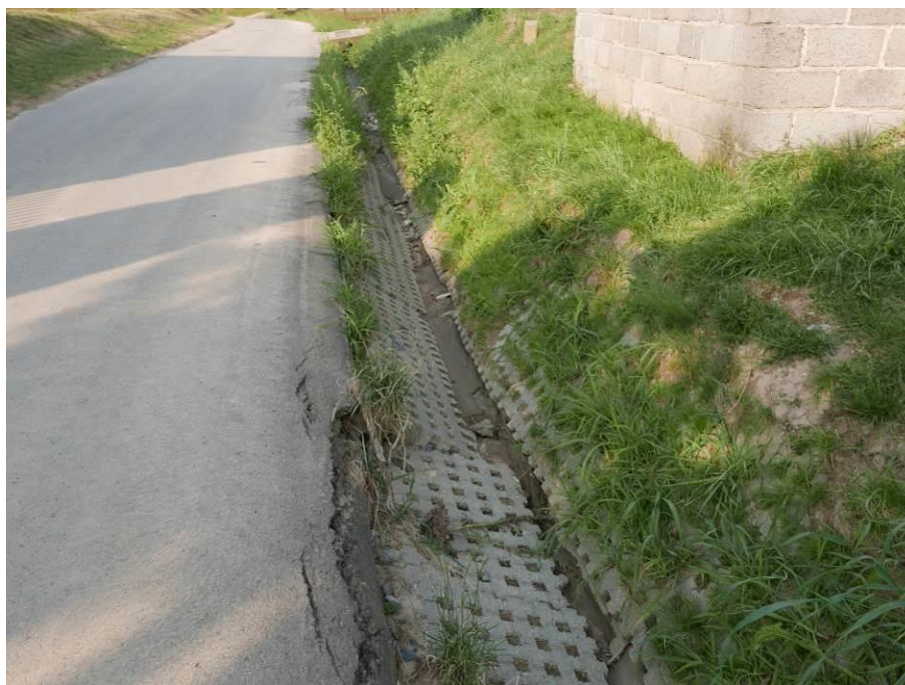
Fot. 61. Widok w kierunku koryta cieku
