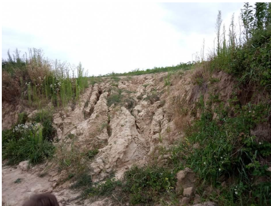
Fot. 26. Ślady spływu z pól powyżej drogi dojazdowej do pól w zlewni nr 5
