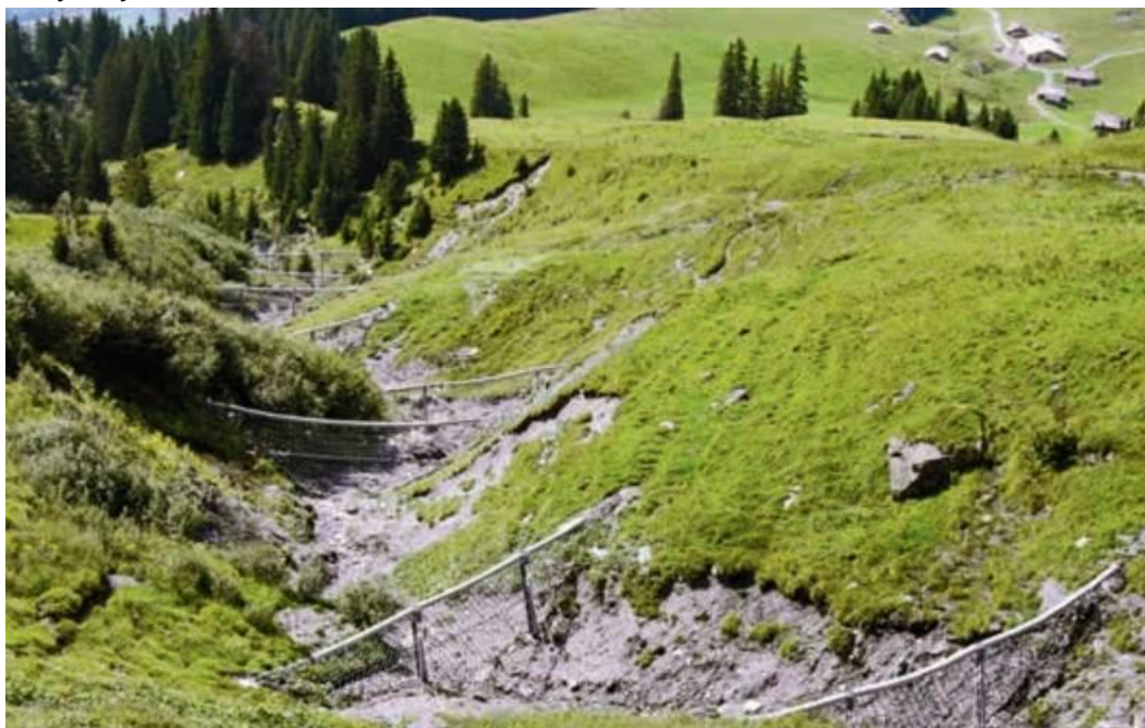
Rysunek 27. Przykładowe elastyczne zapory przeciwrumowiskowe, na podstawie „Możliwości zastosowania elastycznych zapór przeciwrumowiskowych”
