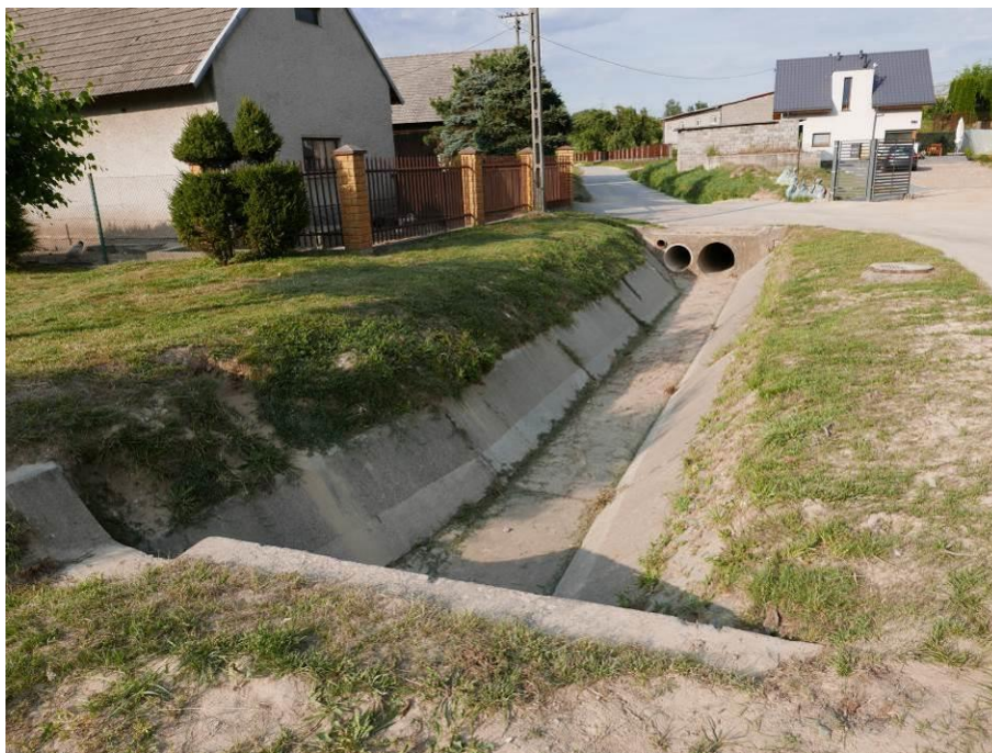
Fot. 66. Widok z drogi powiatowej w górę cieku
