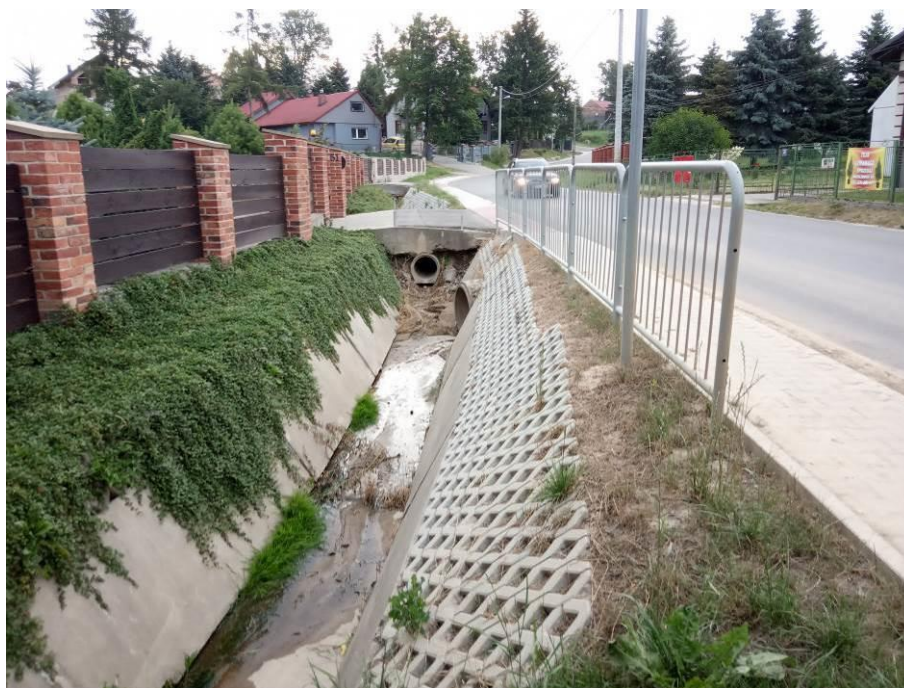
Fot. 4. Prawostronny rów przydrożny, miejsce złączenia wód z kd oraz rowu lewostronnego (wylot z przepustu) - Raciborowice
