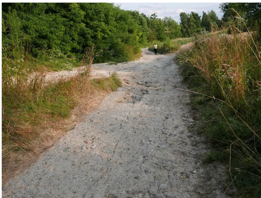
Fot. 47. Złączenie zlewni 3 i 6 z widokiem na drogę dojazdową z destruktu bitumicznego.
