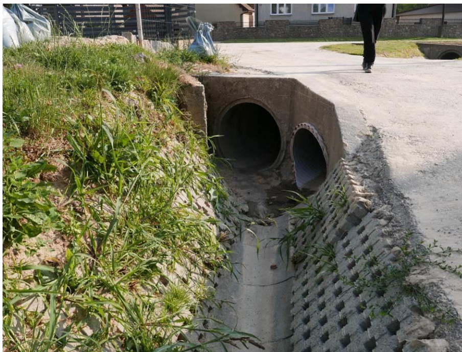
Fot. 64. Skośny przepust typu okularowego
