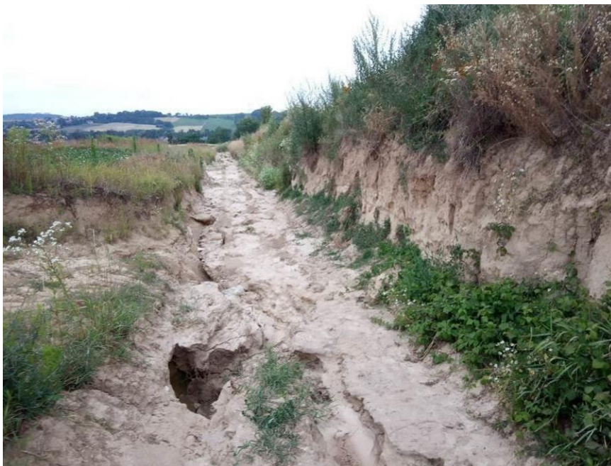
Fot. 24. Zerodowany teren drogi dojazdowej do pól
