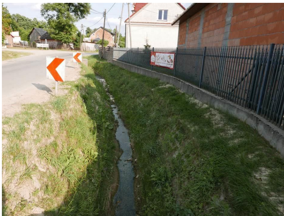
Fot. 68. Ubezpieczenie koryta kratami ażurowymi
