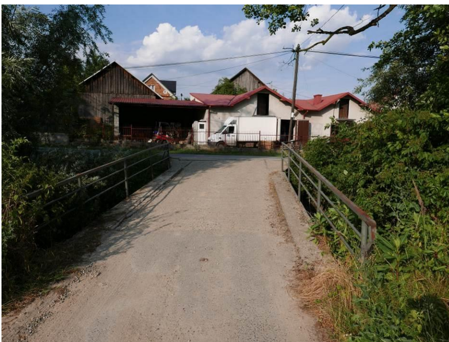
Fot. 79. Most drogowy powyżej ujścia ciek do Młynówki Dłubni.
