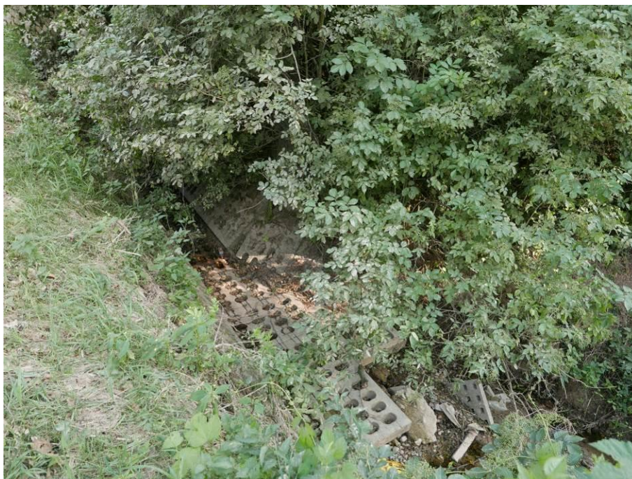
Fot. 76. Odcinek ujściowy ciek
