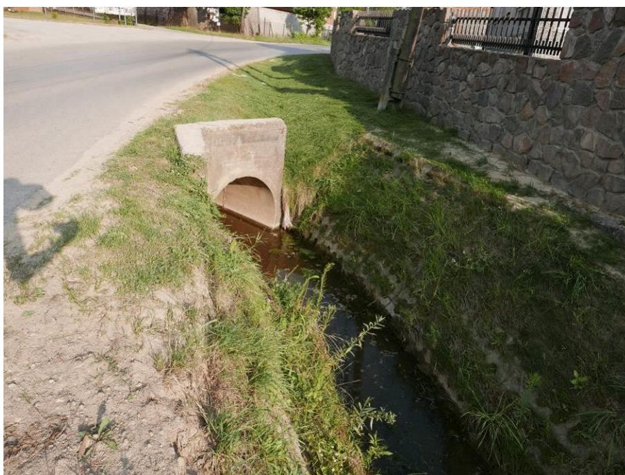
Fot. 67. Wylot z przepustu pod drogą powiatowa
