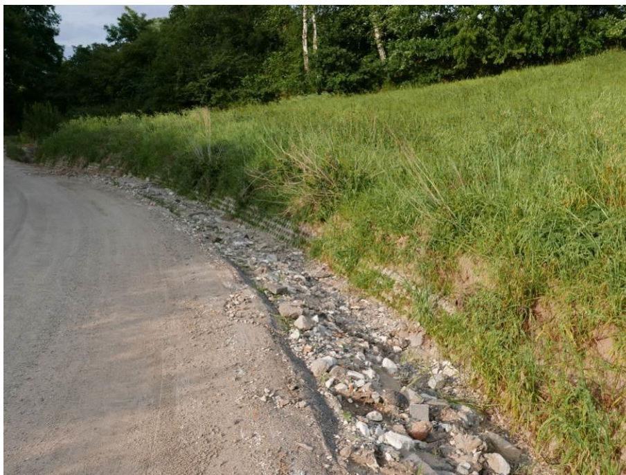
Fot. 50. Widok w kierunku koryta ciek
