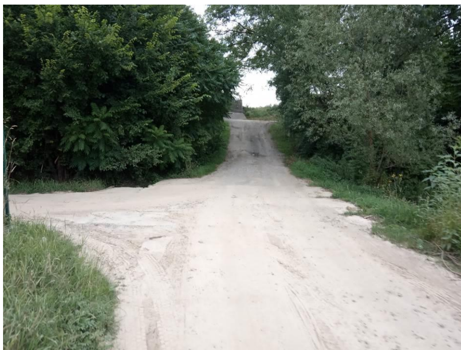
Fot. 16. Przepust pod drogą dojazdowa do zabudowań – zlewnia 2 - Raciborowice
