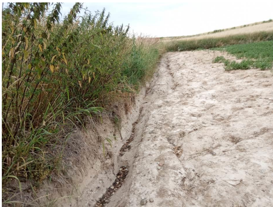
Fot. 33. Pogłębiająca się erozja pola uprawnego spowodowana wmywaniem w sąsiedztwie drogi dojazdowej
