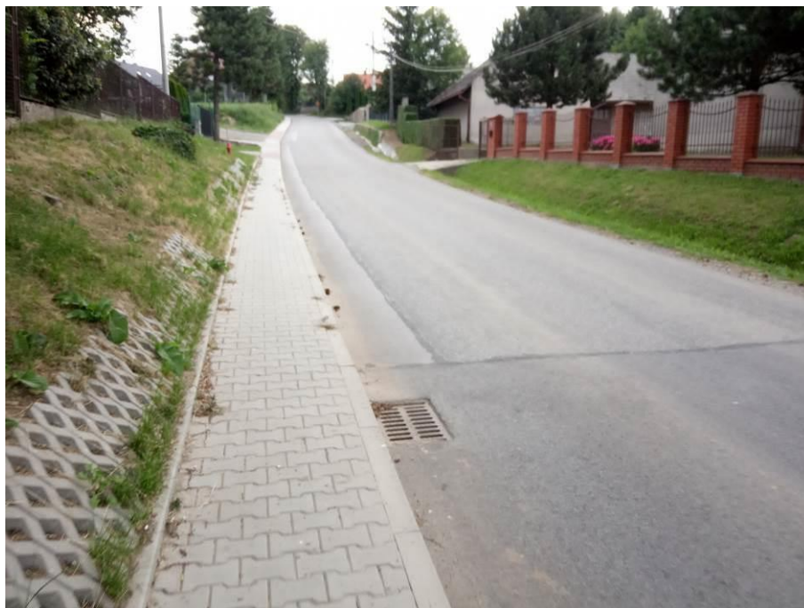
Fot. 2. Widok na lewostronny rów przydrożny oraz prawostronną kanalizację deszczową - Raciborowice
