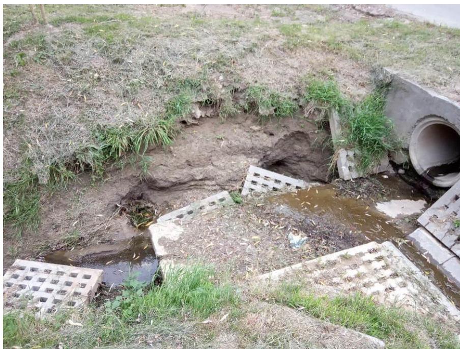
Fot. 6. Zdewastowane koryto poniżej przepustu w ul. Cichej koło placu zabaw - Raciborowice
