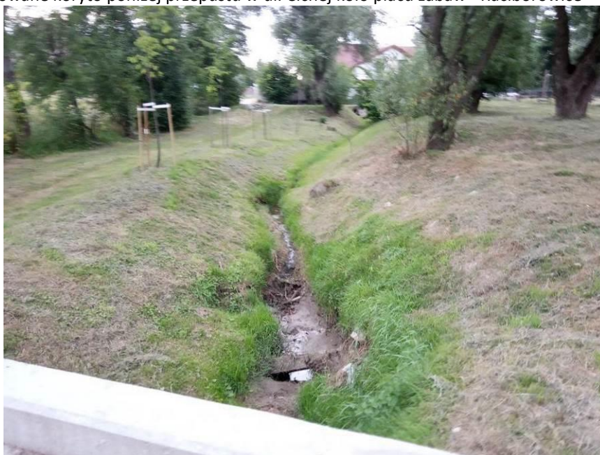
Fot. 6. Zdewastowane koryto poniżej przepustu w ul. Cichej koło placu zabaw - Raciborowice
