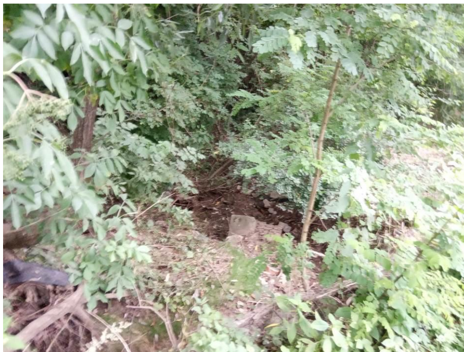
Fot. 18. Przepust pod drogą dojazdową do zabudowań wylot – zlewnia 2.
