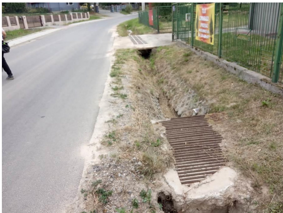
Fot. 3. Studnia wpadowa na rowie przydrożnym - Raciborowice
