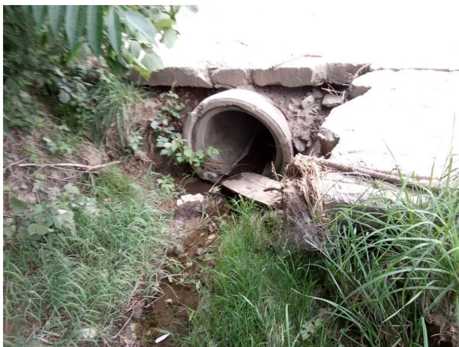
Fot. 17. Przepust pod drogą dojazdowa do zabudowań wlot – zlewnia 2- Raciborowice
