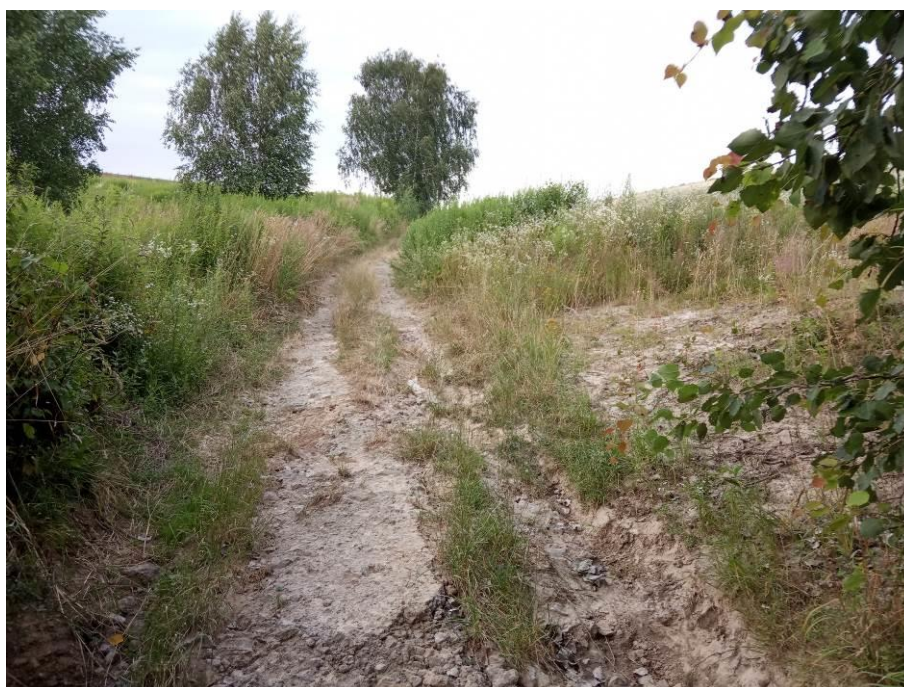
Fot. 35. Widok na drogę dojazdową do pól – destruktu bitumiczny
