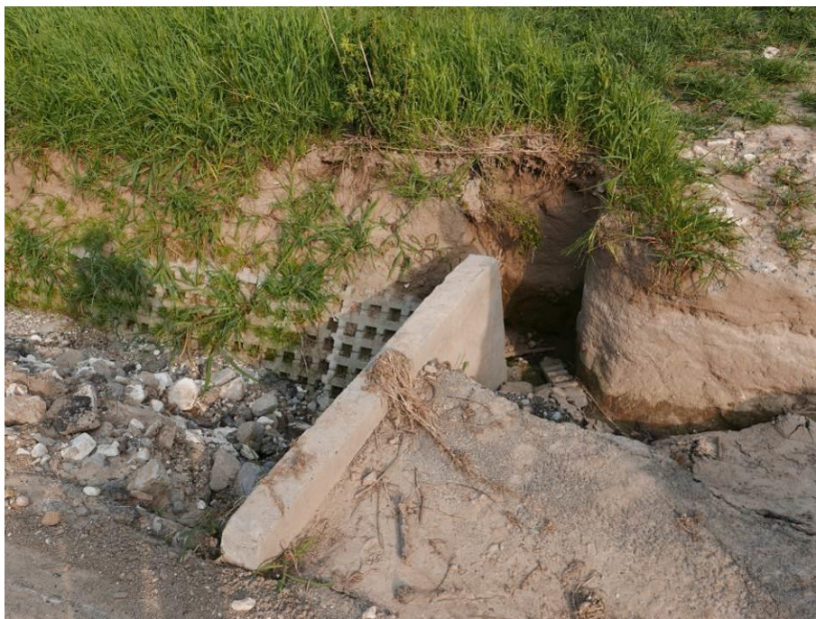
Fot. 52. Zniszczony przepust i zjazd do pól
