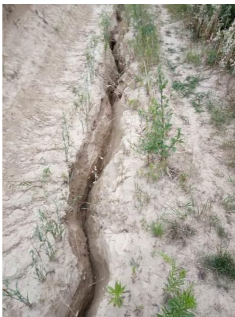
Fot. 25. Erozja wgłębna drogi dojazdowej do pól
