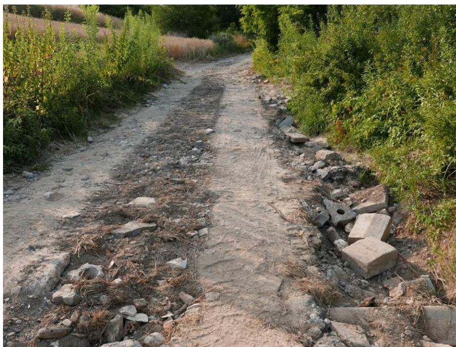
Fot. 44. Zniszczona droga dojazdowa w zlewni nr 6
