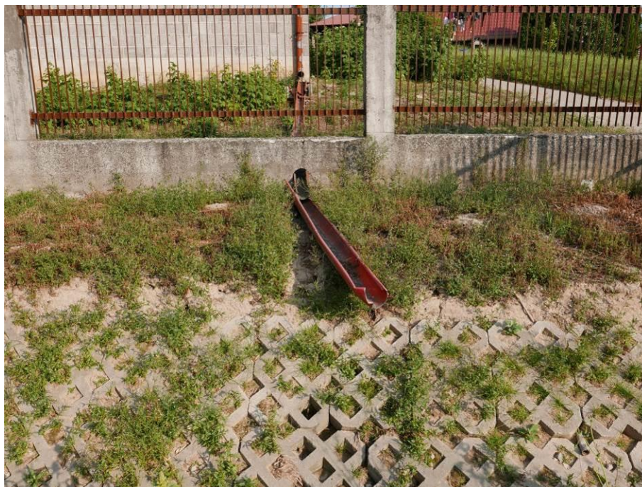
Fot. 60. Wylot odwodnienia z terenu posesji
